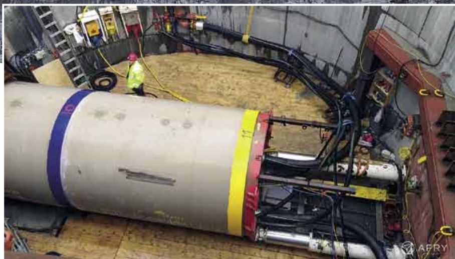
Turun sataman alueella sijaitsevan aloituskaivannon kautta tunkattiin Turun maaperään yhteensä 200 kappaletta neljän metrin mittaista betoniputkea.
