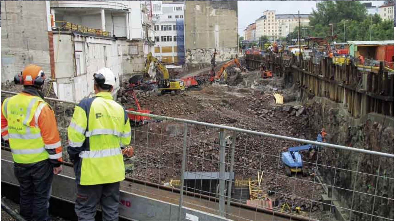
OP-Pohjolan pääkonttorin rakennustyömaa Vallilassa vuonna 2013.
