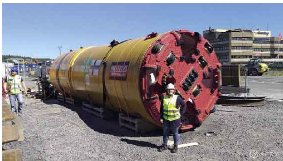
Putken etupäässä kulkeva TBM-porausyksikkö on suunniteltu erityisesti tähän hankkeeseen. Porausyksikkö on suunniteltu siten, että sillä voidaan edetä sekä pehmeässä savessa että kovassa moreenissa. Suuretkaan kivenlohkareet eivät aiheuttaneet ongelmia laitteistolle.
