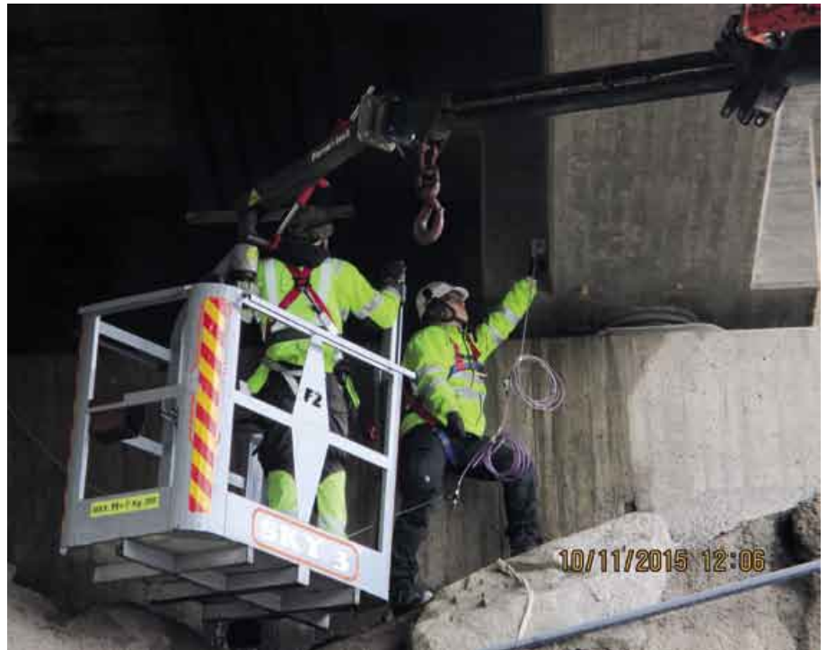
Tripla: Tärinämittarin asennukseen tarvittiin nostinta Pasilan Triplan työmaalla.
