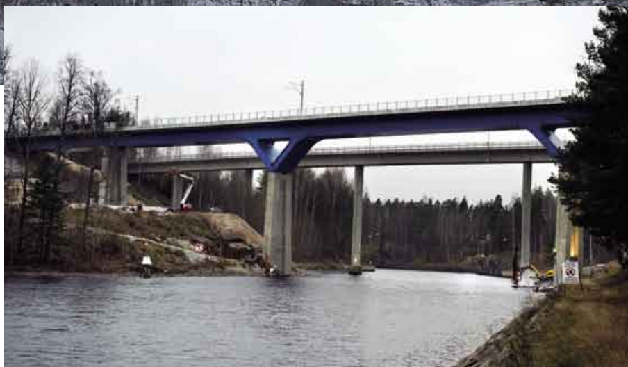
Työmaan vieressä on vilkkaassa käytössä oleva uusi, juhannuksena 2020 liikenteelle avattu ratasilta.
