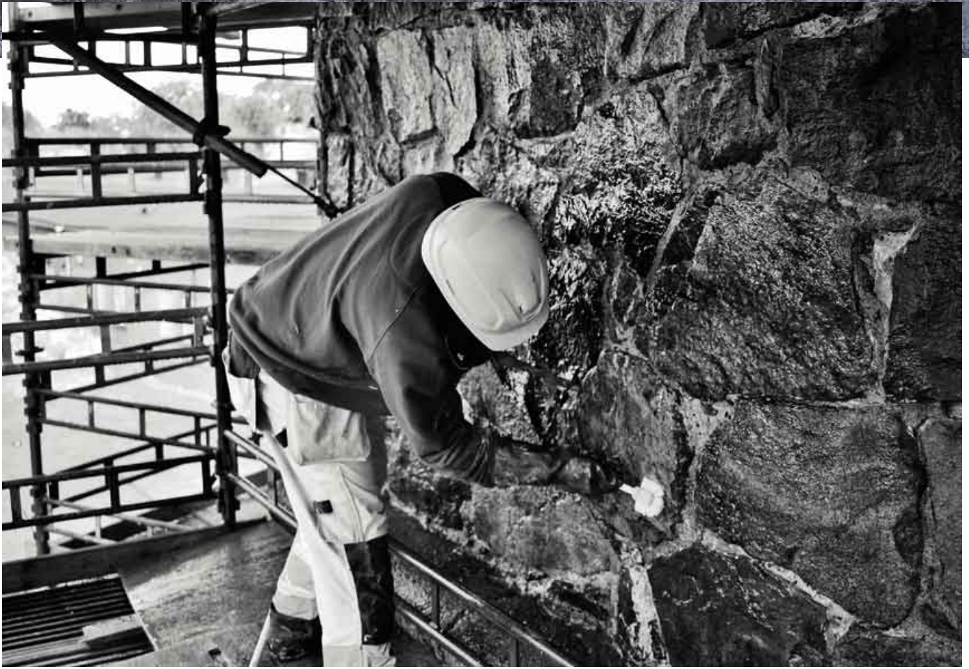
Syvätyötetty ja uudelleen kiilattu muuri joudutaan pesemään huolellisesti, sillä laasti likaa kivipintaa. Vankilan työmaa Bastioni Härle- manilla. (Valokuva Andrea Poiret 2017.)
